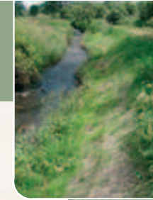
Aménagement d'une berge en pente douce grâce au génie végétal
