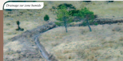
Drainage sur zone humide
