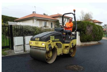
*(enrobé fabriqué aux alentours de 180°C, dans une centrale d'enrobage et qui sera transporté à chaud vers le chantier d'épandage, pour former la couche supérieure du revêtement ; il est mis en œuvre à une température d'environ 150 °C au moyen d'un finisseur)*
