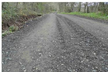
**Chemin de la Vernède (9 000 Euros) :** remise en état correcte de circulation, curage du fossé pour l'écoulement des eaux pluviales afin d'éviter le ravinement par ruissellement, nivellement et mise en place de concassé, puis damage de la bande de circulation.
